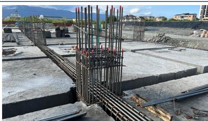
基礎地梁鋼筋綁紮
