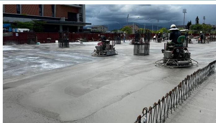
一樓板高平整地坪作業
